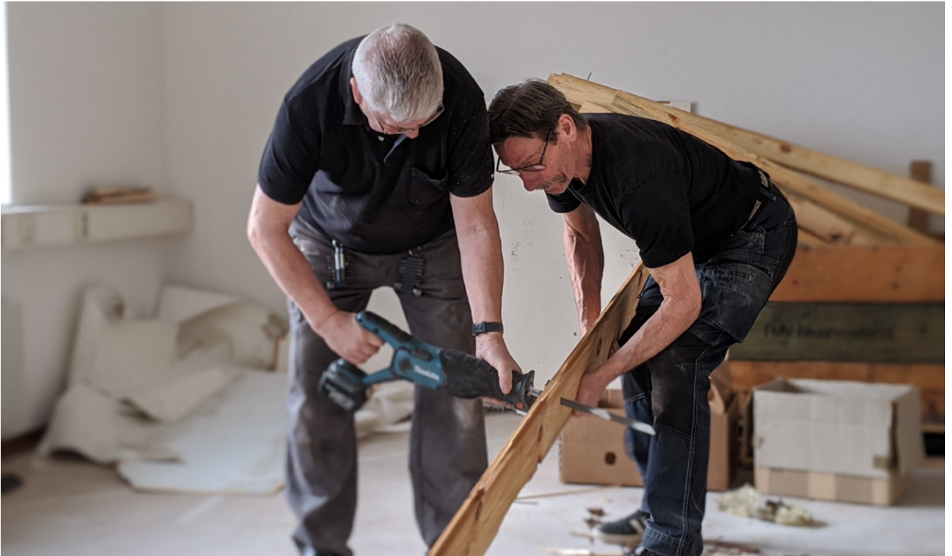
Pågående byggnation på Lekoseum. Foto: Lekoseum.
