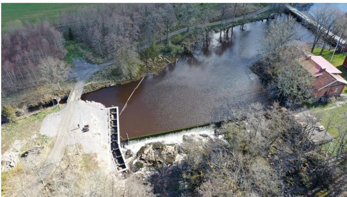
Den tekniska fiskvägen är placerat till vänster om dammvallen. Ovanför den går inloppet till kanalen som leder till kraftverket. Inloppet skyddas från eventuella flytande grenar eller annat material som kan skada eller sätta stopp i kraftverket av en barriär. Foto Robin Eriksson, Förvaltningen för kulturutveckling.
