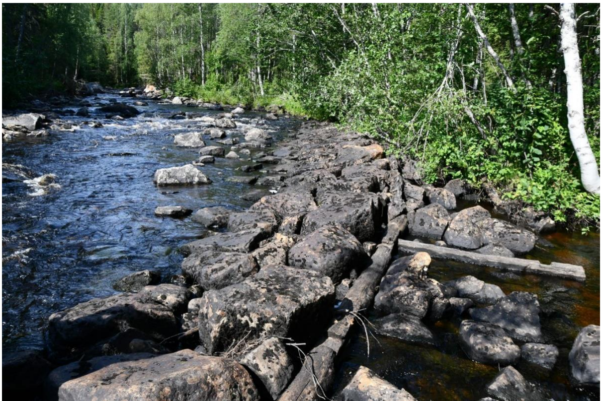
Kallmurad flottningslämning, släntmur i Dödmansforsen. Foto Mattias Lindholm, Förvaltningen för kulturutveckling
