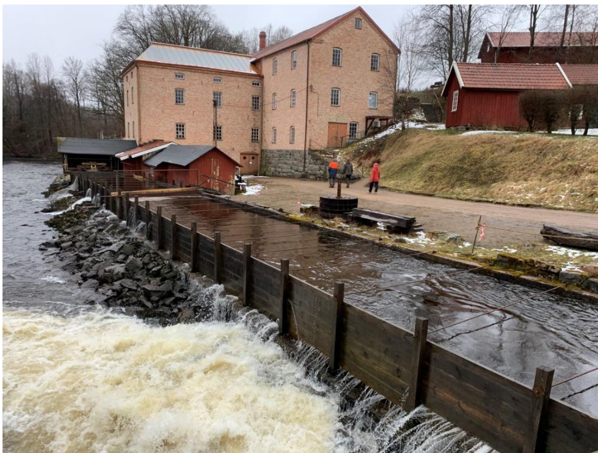
Hillefors grynkvärn med vattenränna som löper in mot turbinen som idag återigen efter renovering driver kvarnmaskinerna. Foto: Hans Hellman, Förvaltningen för kulturutveckling.
