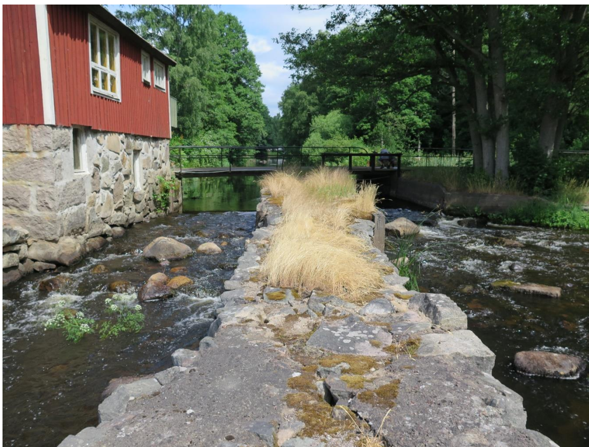
Foto från söder. Den f.d. kvarnen syns till vänster. Dammluckorna är borttagna och sten har lagts i vattenfåran. Foto Hans Hellman, Förvaltningen för kulturutveckling.
