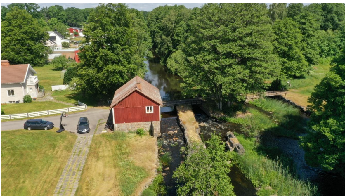
Kvarnen angränsar till tidigare industrimark som idag brukas som trädgårdsland. Vattendraget har stensatta kanter och sten har lagts ut för att skapa forsande vatten och lugnare platser där fisken kan vila. Foto Robin Eriksson, Förvaltningen för kulturutveckling.
