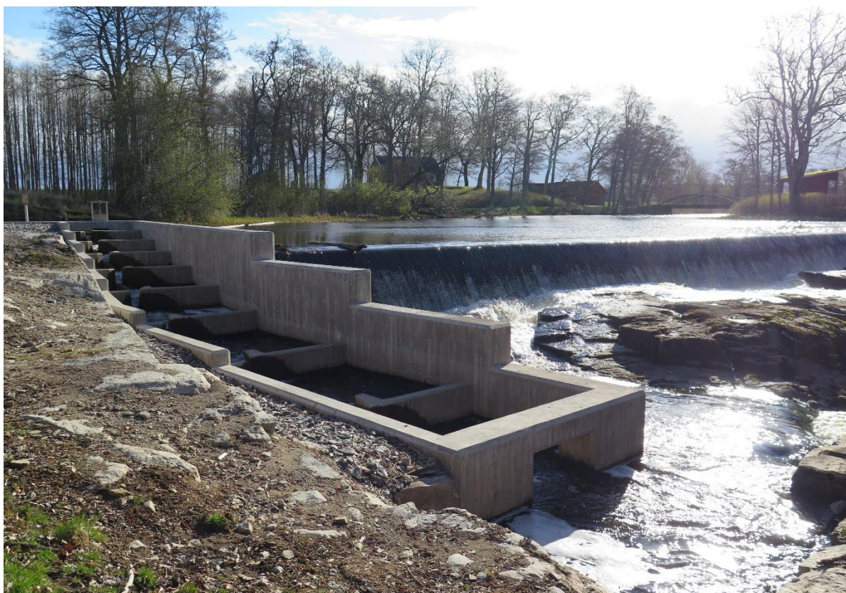
Foto från väster. Fiskvägen i förgrunden och bakom ses den ursprungliga dammtröskeln. Utanför bild till höger ligger hembygdsgården. Foto Hans Hellman, Förvaltningen för kulturutveckling.
