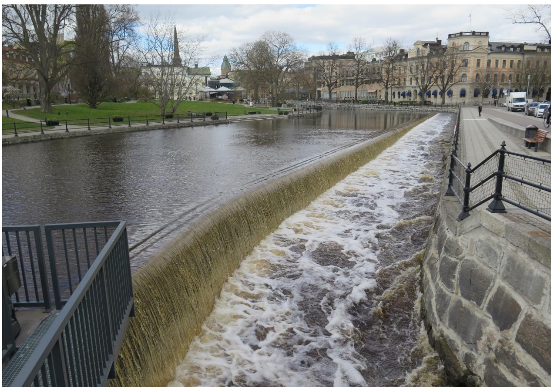
Foto från söder. Här faller vattnet över betongtröskeln och tillsammans med det strömmande vattnet så har detta uppfattats som ett störande buller. Utformningen känns däremot mer tilltalande som en del av stadsmiljön. Foto Hans Hellman, Förvaltningen för kulturutveckling.
