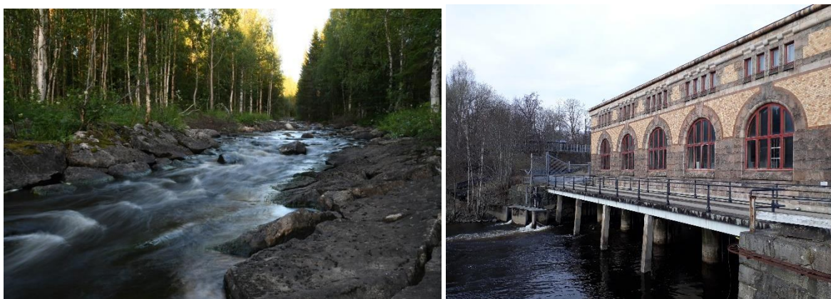
Sträcka av Svartån i Rickleåns avrinningsområde, Skellefteå kommun, med spår av flottning. Till höger kraftstationen vid Jonsered öster om Göteborg med byggnad ritad av Hans Hedlund. Längst bort i bilden syns mynningen till laxtrappan. Foto: Mattias Lindholm och Marie Odenbring Widmark Förvaltningen för kulturutveckling.
