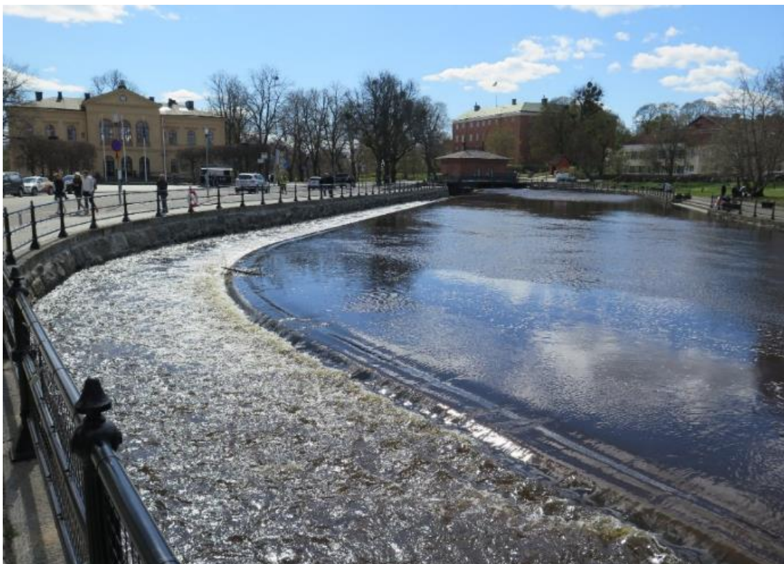
Faunapassagen sedd från norr, rådhuset till vänster i bilden. Bakom turbinhuset syns slottet. Foto Hans Hellman, Förvaltningen för kulturutveckling.
