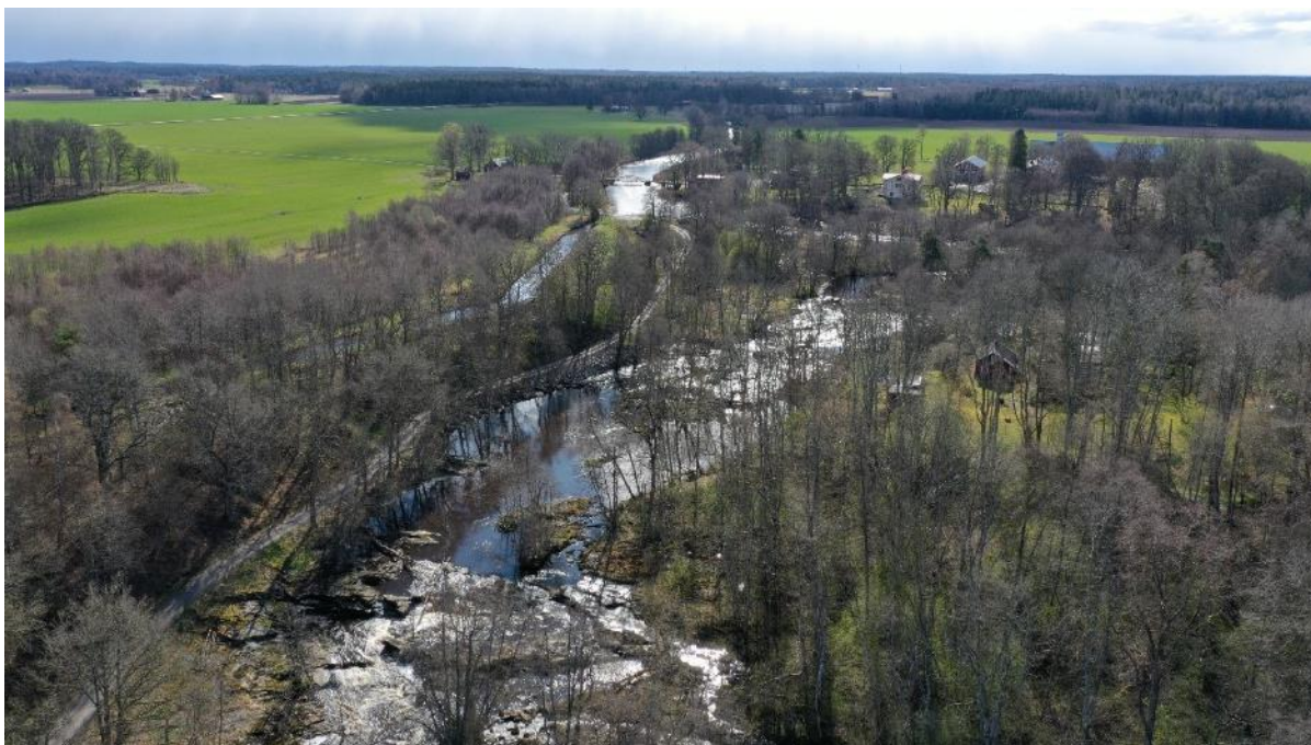
Nedströms dammen rinner Nossan över ett estetiskt tilltalande vattenlandskap med berghällar och kvillar med träd och lågor. Ovanför Nossan leder kanalen till kraftverket som ligger precis utanför bilden i nedre vänstra hörnet. Till höger i bilden har det tidigare legat ett tegelbruk. Foto Robin Eriksson, Förvaltningen för kulturutveckling.
