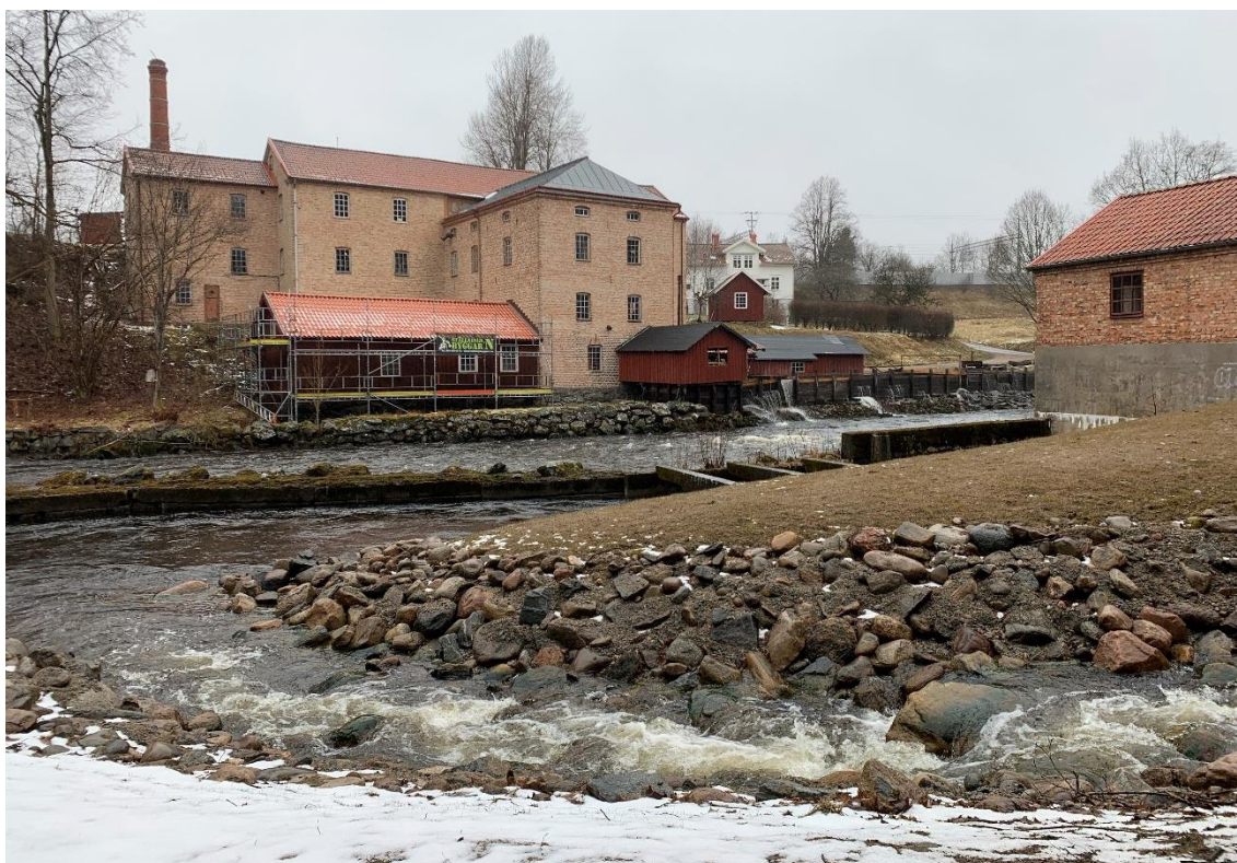
Foto från sydost. I förgrunden ses omlöpet, på andra sidan Säveån ligger byggnadsminnet Hillefors grynkvarn och till höger ligger kraftverket. Foto Hans Hellman, Förvaltningen för kulturutveckling.
