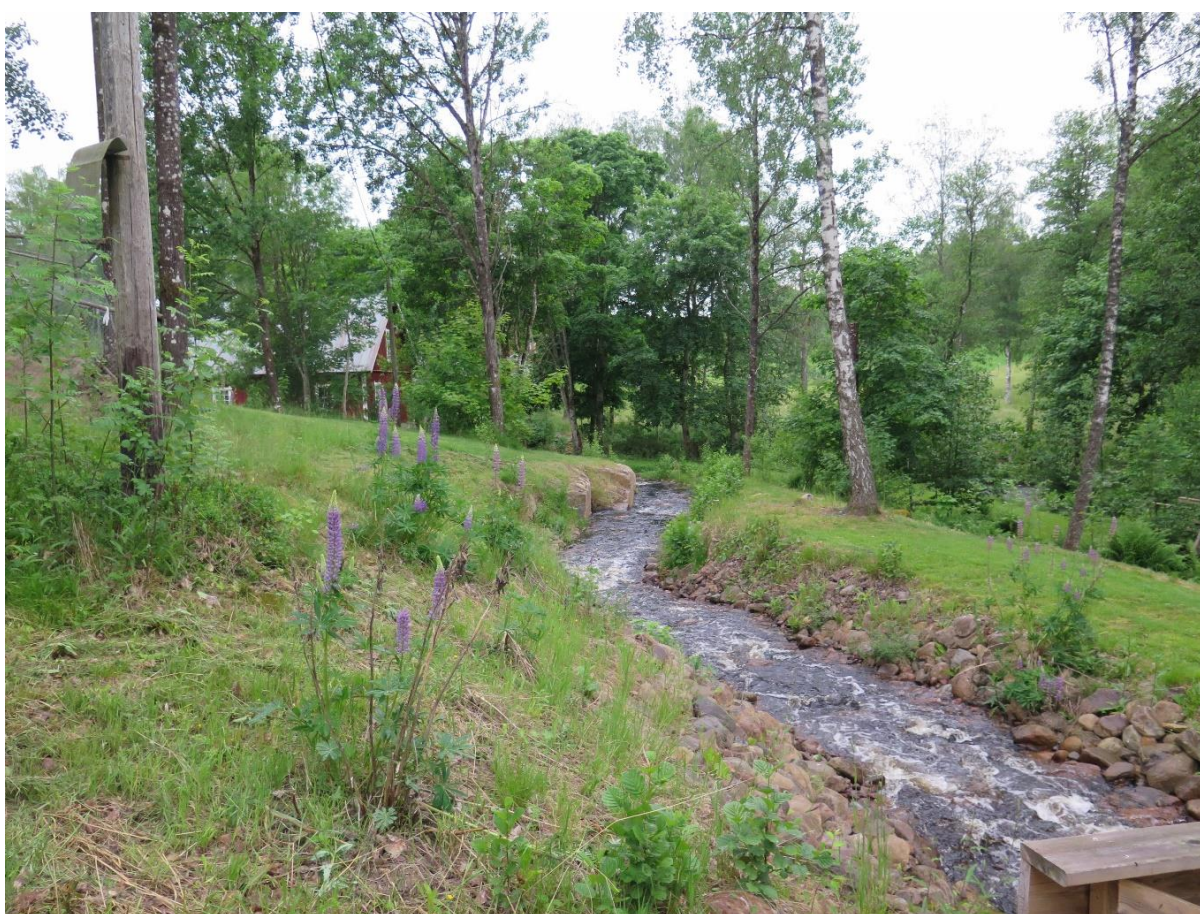
Foto från nordost. Omlöpets utformning smälter bra in i den omgivande miljön. I bakgrunden syns kvarnen. Foto Hans Hellman, Förvaltningen för kulturutveckling.
